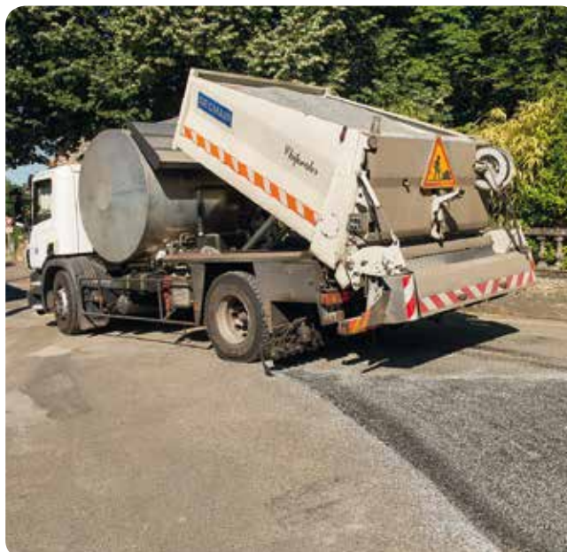
Réparation de chaussée au « point à temps »
